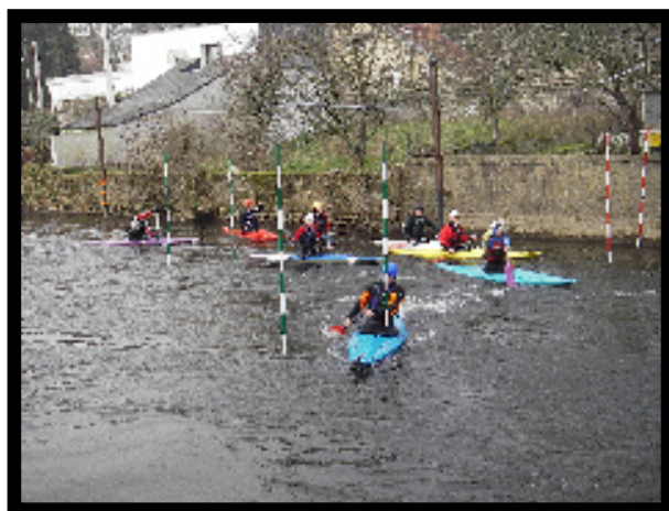
Barrage de Lochrist 3 clapets « sécurités » travaux en cours.
